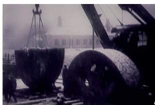
Svinghjul og krumtap til 4200 hk dieselmotor ankommer med banen i november 1950
